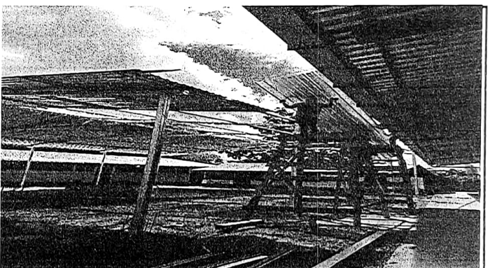
Foto 4: Continuación de instalación de lamina troquelada, calibre 6
