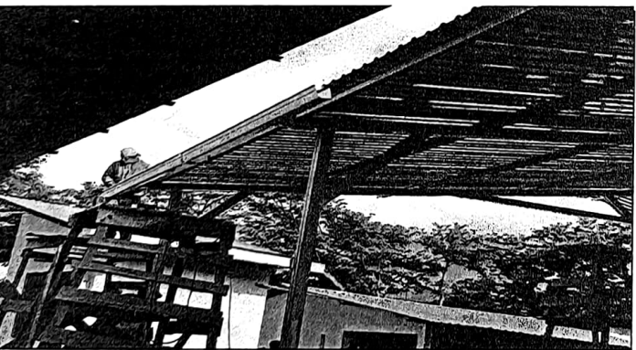
Foto 5: Instalación de canal PVC
